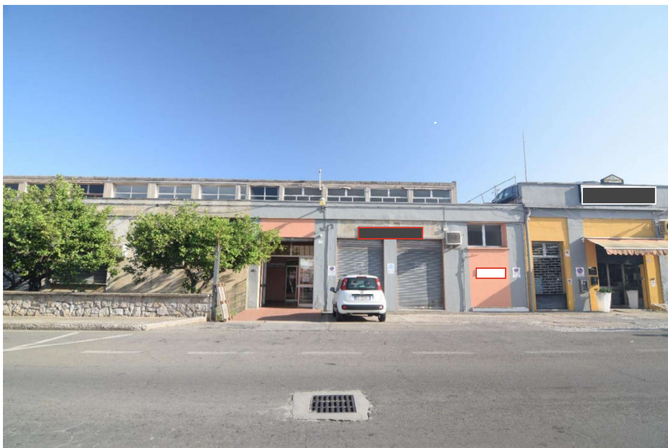
Foto 1. Complesso commerciale – Cagliari via Dolcetta n. 23
